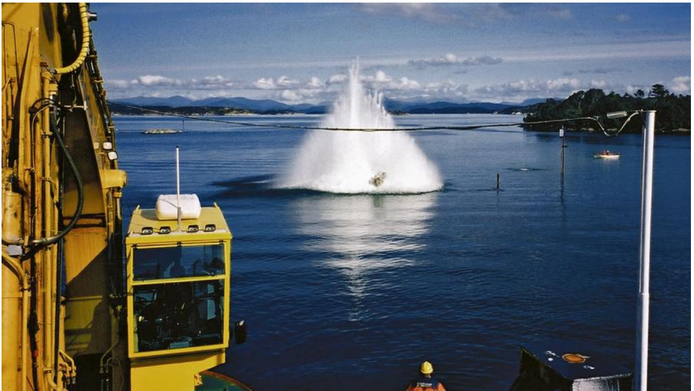
Blasting in Torangsvåg, Bergen.
